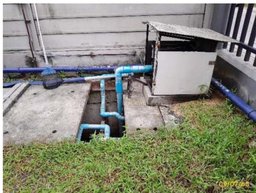
บ่อพักน้ำสุดท้ายก่อนระบายลงรางสาธารณะ
